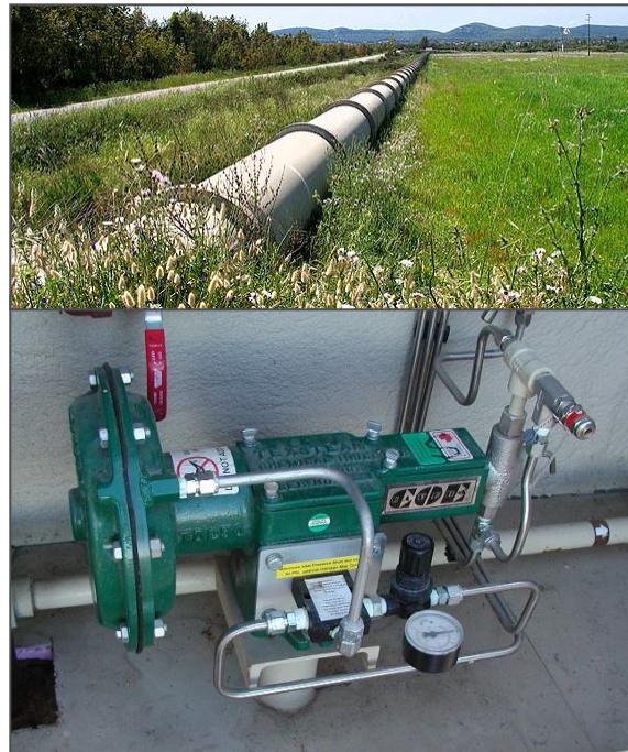
Насосы-дозаторы для впрыскивания химических реагентов(Австрия)
