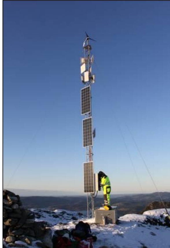
Ретрансляционная станция (Норвегия) EFOY Pro в специальной изоляции
