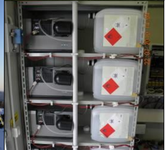
Ретрансляционная станция (Норвегия) EFOY Pro в специальной изоляции
